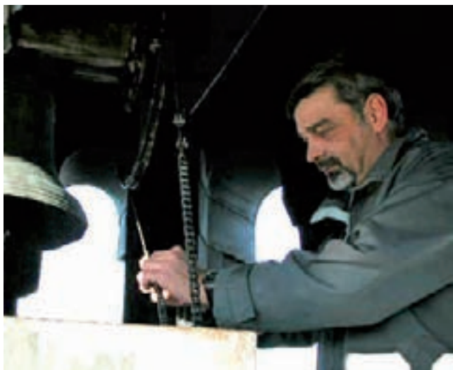
Kirketjener Henrik Ravn kontrollerer skoleklokkens ringemaskine, som kræver jævnlig service. Turen op på og hen over kirkeloftet til rytterspiret er lang – til gengæld er både udsigten og den automatiske ringning en fornøjelse.
