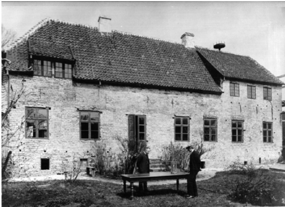
Puggaards sydside efter ombygningen 1912-13. Murværket er afrenset, og spor efter ældre åbninger bevaret. Den høje del har fået stejlere taghældning, og de frie gavle er blevet udstyret med kamtakker. Foto i Den Antikvariske Samling.
