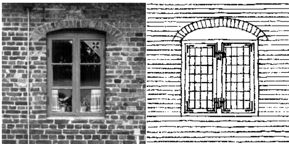
Det kurvehanksbuede, murede stik bærer murværket over vindueshullet, og karmen har båret en udmuring op til det murede stiks underside. Vinduerne vides at have haft oplukkelige rammer med små ruder i blysprosser, men selve rudeinddelingen er ukendt og her kun angivet som princip. SMS 1994.
